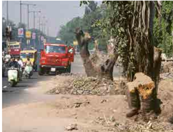
Alter Baumbestand wird dem Straßenausbau geopfert. Foto: Rainer Hörig
