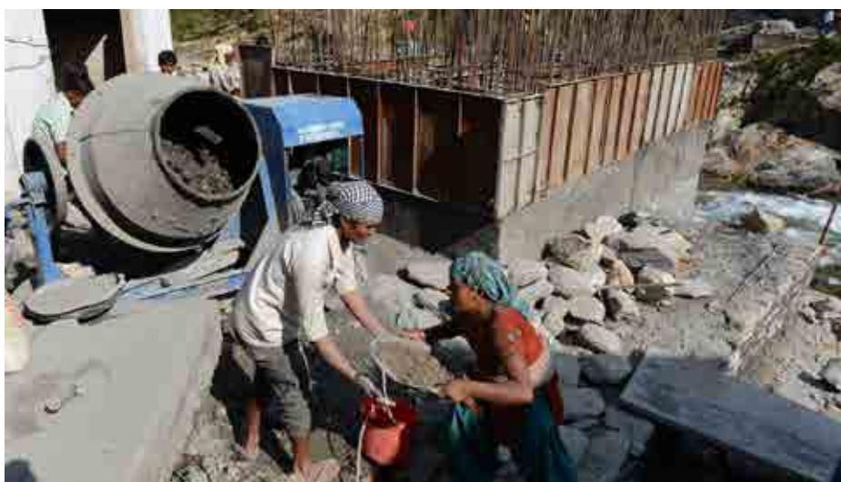
Wiederaufbau eines Brückenpfeilers in Kalimath
