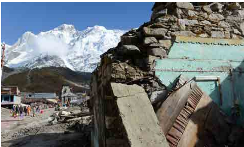
Von der Schlammflut zerstörte Häuser in Kedarnath Foto: Dierk Jensen
